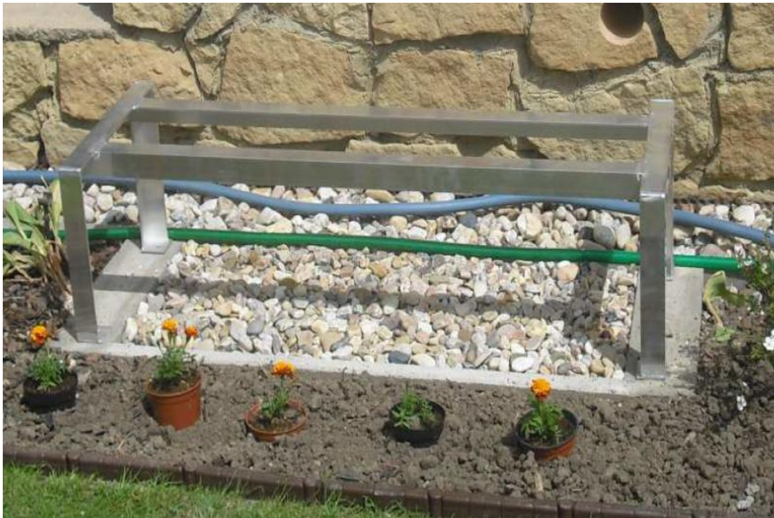
Obrázok 5: Ukážka prevedenia základu pre tepelné čerpadlo
